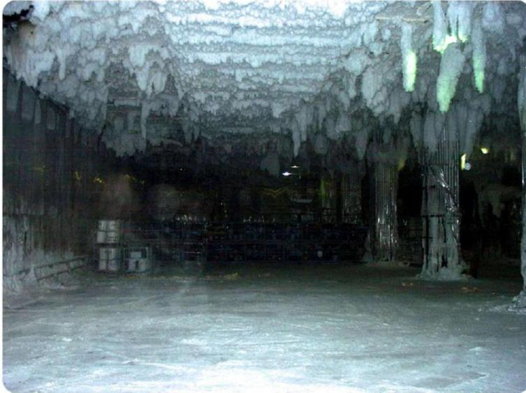
Adsorptionstrockner können angewandt werden, um Vereisungen in Kühlräumen vorzubeugen, indem sie der Luft das Wasser entziehen, so sinkt der Taupunkt und die Anlage bleibt eisfrei.
